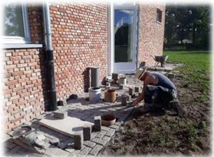
Erik legt de klinkers.
