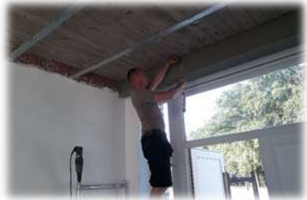
Aan het plafond wordt gewerkt
