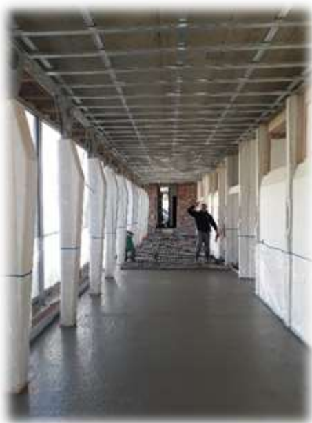
De vloer wordt gegoten.
